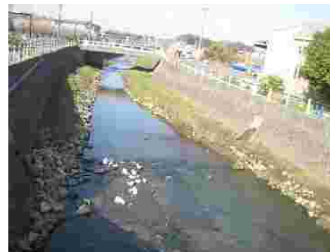
浜道橋から上流。瀬や淵ができ、アユの遡上も期待できる。
