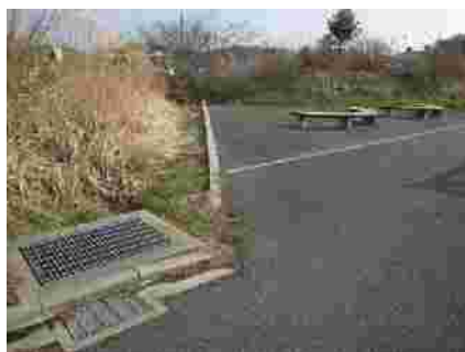
立之下橋ミニ広場に接してマコモにおおわれた土水路がある。
